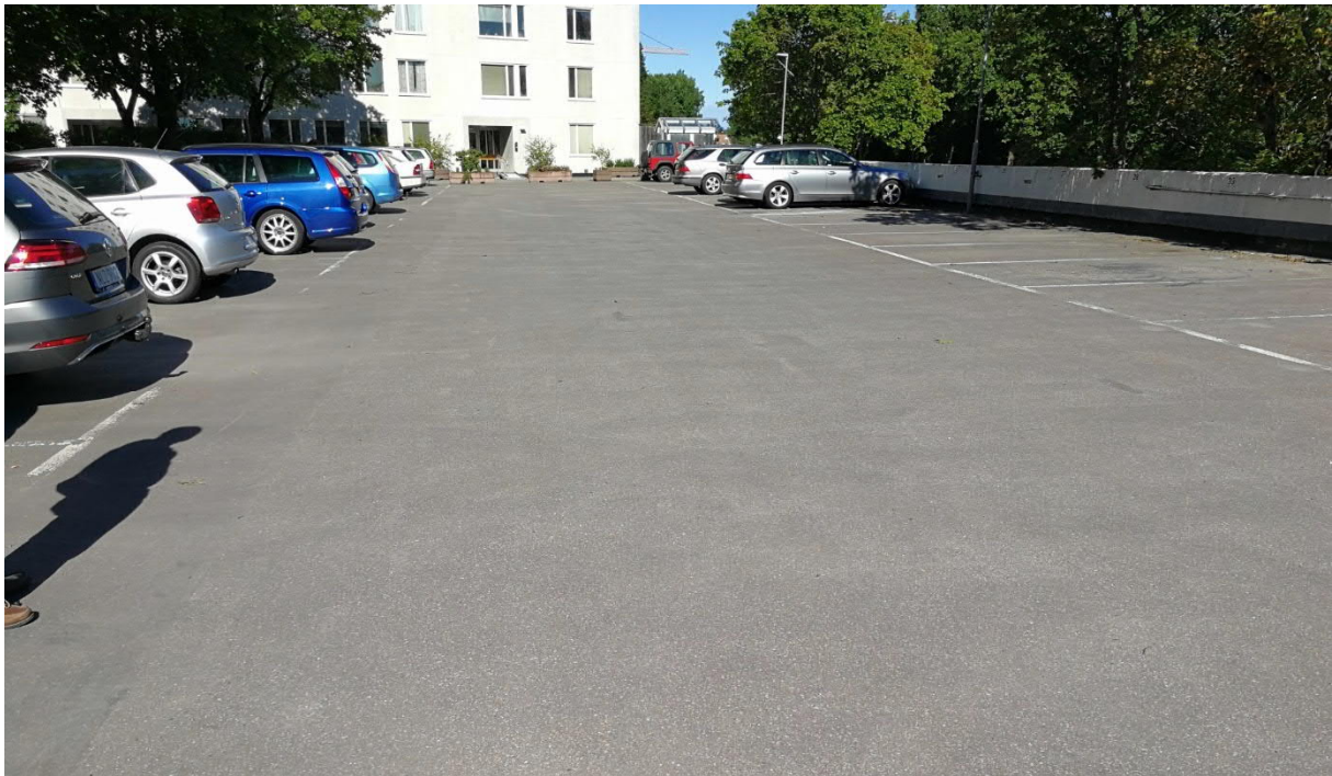
Figur 1. Parkeringsdäck med gjutasfalt som slitlager, Märbydalen 6 182 52 Danderyd.
